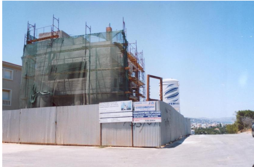
Φωτ. 2.2-20: Εξοχική κατοικία υπό ανέγερση στο Ασκηταριό
